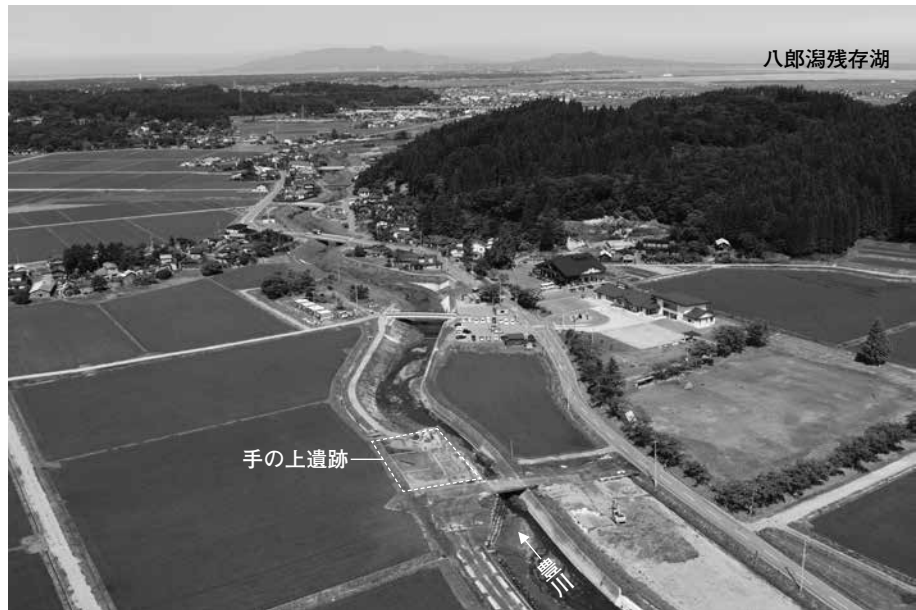
調査区遠景 (東側上空から)
