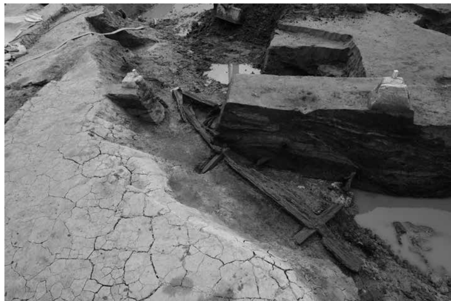
河川内の護岸遺構(古) (西から)
